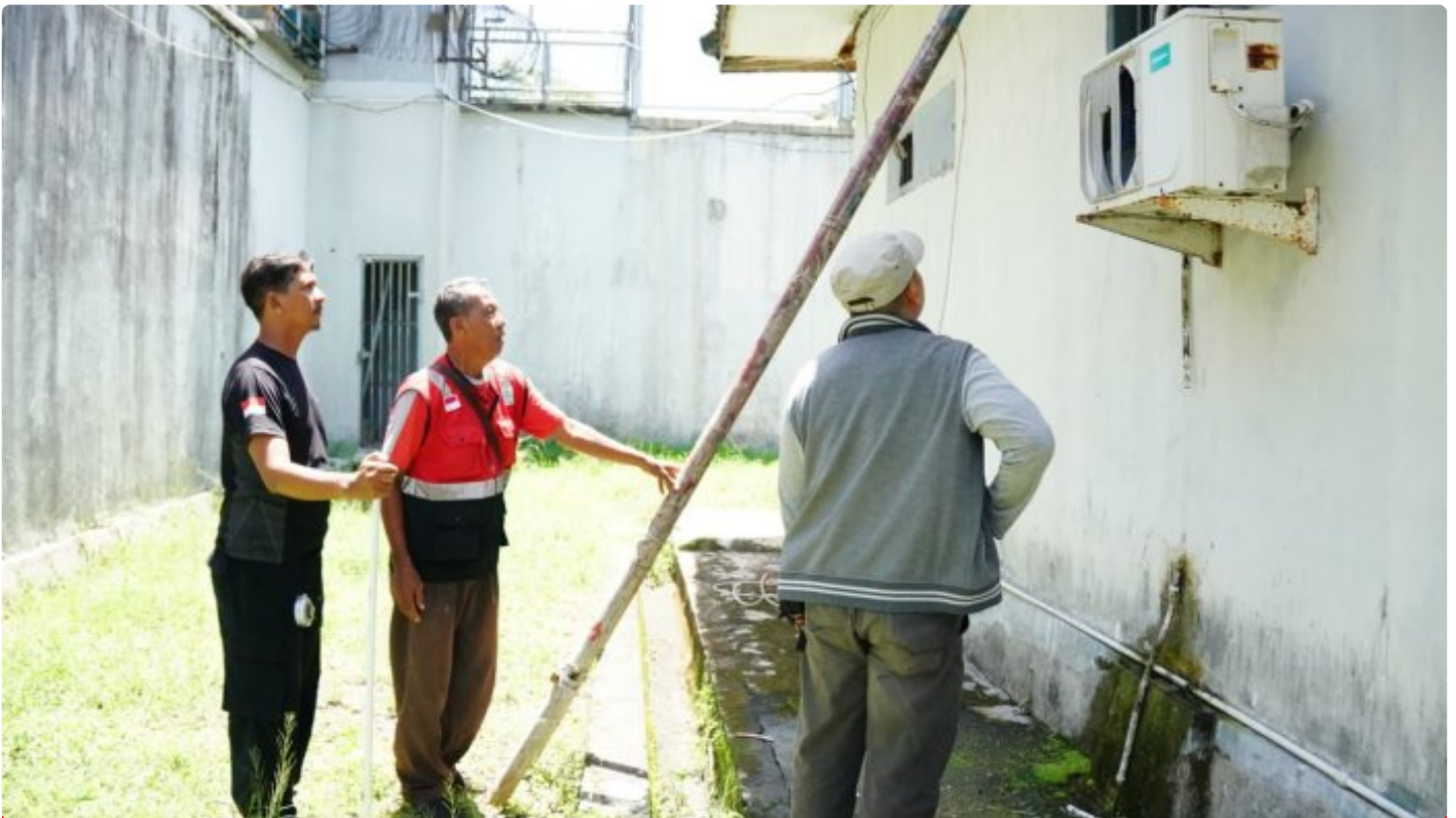
Antisipasi Gangguan Pasokan Listrik, Lapas Besi Lakukan Pemeliharaan Jaringan
